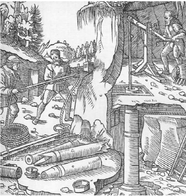
Abb. 625: Drückelpumpe. Die Säule A. Die Welle B. Der Schwengel, der sich um die Achse dreht C. Die Kolbenstange D. Der Griff E. Der Ring, durch den die beiden Rohre verbunden werden F.
