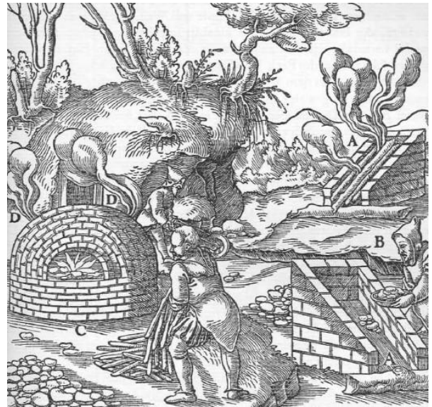
Abb. 808: Das Rosten von Bleierz in Stadeln und im Röstofen. Ein brennender Röststadel mit Bleierz und darauf gelegten Hölzern A. Ein Arbeiter trägt auf einen Röststadel Bleierz ein B. Der dem Backofen ähnliche Röstofen C. Öffnungen, aus denen der Rauch herausdringt D.
