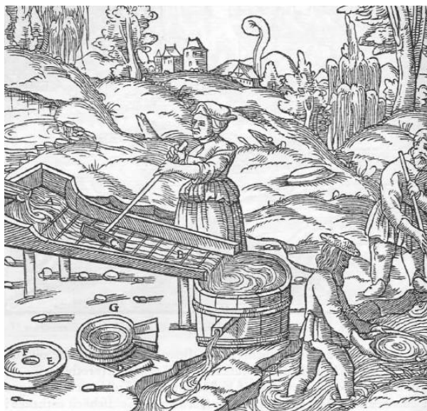
Abb. 842: Das Verwaschen der Golderze auf dem Herde mit Querleisten. Das Haupt des Herdes A. Die Querleisten B. Die Kiste C. Das zugespitzte Hölzchen D. Eine Waschschiessel E. Die Vertiefung in der Mitte F. Eine Waschschiessel mit Rillen G.
