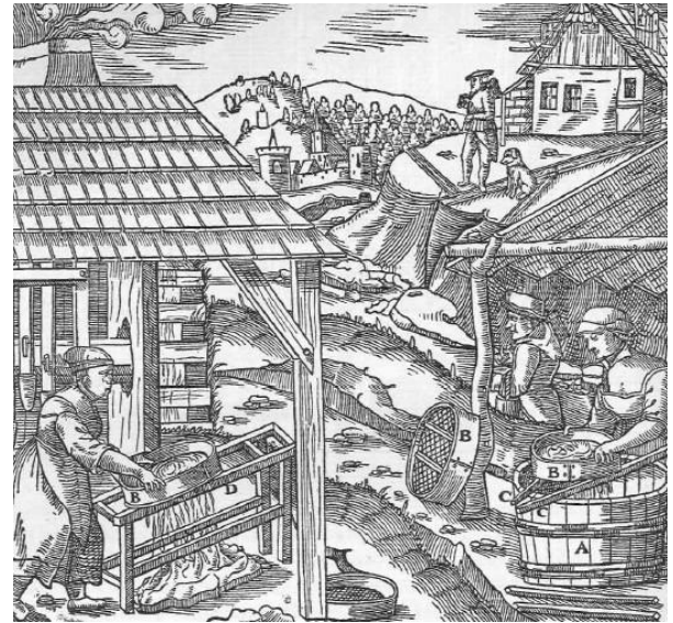
Abb. 910: Siebe zum Absieben des Kohlenpulvers. Das Sammelgefäß A. Das Sieb B. Die Stäbe C. Der bankartige Rahmen D.
