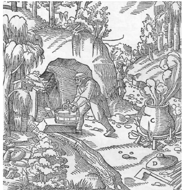
Abb. 1221: Die Gewinnung von Bitumen aus Wässern, Rohbitumen und Gesteinen. Die bitumenhaltige Quelle A. Der Bottich B. Das kupferne oder eiserne Gefäß C. Der Deckel D.
