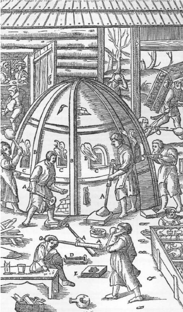
Abb. 1226: Dritter Glasofen zur Herstellung fertiger Glaswaren. Die Pfeifen A. Die kleinen Fenster B. Die Marmorplatten C. Die Zange D. Formen für die Gestaltung der Glaswaren E.
