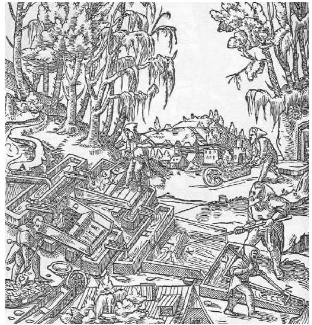
Abb. 859: Das Waschen der Zinnerze im Trog und auf dem Herd. Das kleine Gerinne A. Das Quergerinne B. Zwei andere kleine Gerinne C. Die Tröge D. Die Bleche E. Die Gitter F. Die Stäbe G. Das andere Quergerinne H. Der Herd I. Die Kiste K. Das dritte Quergerinne L. Das gerade Gerinne M. Der dreizinkige Krähl N.
