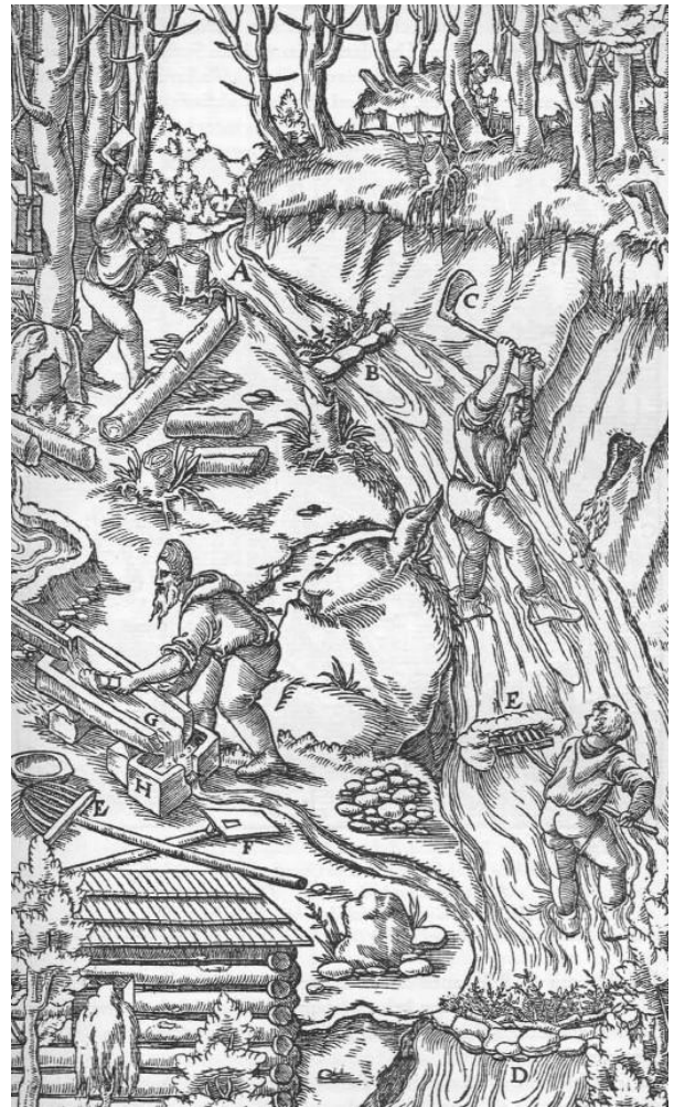
Abb. 853: Das Waschen der Zinnerze im Graben mit der Seifengabel und im Läutertrog. Der Bach A. Der Graben B. Die Breithaue C. Die Rasen D. Die Seifengabel E. Die eiserne Schaufel F. Der Trog G. Ein anderer darunter gestellter Trog H. Eine kleine hölzerne Schaufel I.
