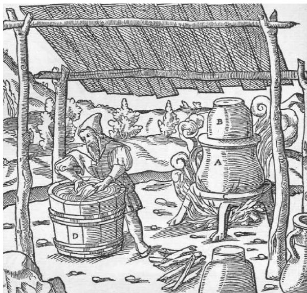
Abb. 929: Quecksilbergewinnung in einem großen Topf, der, auf einem Dreifuß stehend, erhitzt wird. Der größere Topf A. Der kleinere Topf B. Der Dreifuß C. Faß, in dem der Sand verwaschen wird D.
