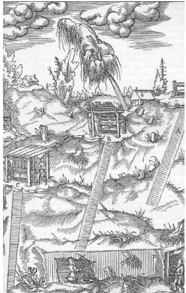
Abb. 502: Ein Stollen und tonnlägige Schächte. Drei tonnlägige Schächte. Der erste Schacht, der noch nicht bis zum Stollen geteuft ist A. Der zweite Schacht, der den Stollen erreicht hat B. Der dritte Schacht, bis zu dem der Stollen noch nicht vorgetrieben ist C. Der Stollen D.
