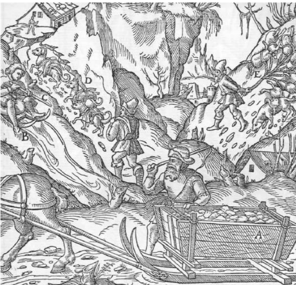
Abb. 618: Schlitten- und Sackbeförderung. Ein Schlitten A. Ein Schleife mit Säcken B. Der Stab C. Die Hunde mit Saumsätteln D. Die an einem Strick befestigten Säcke E.
