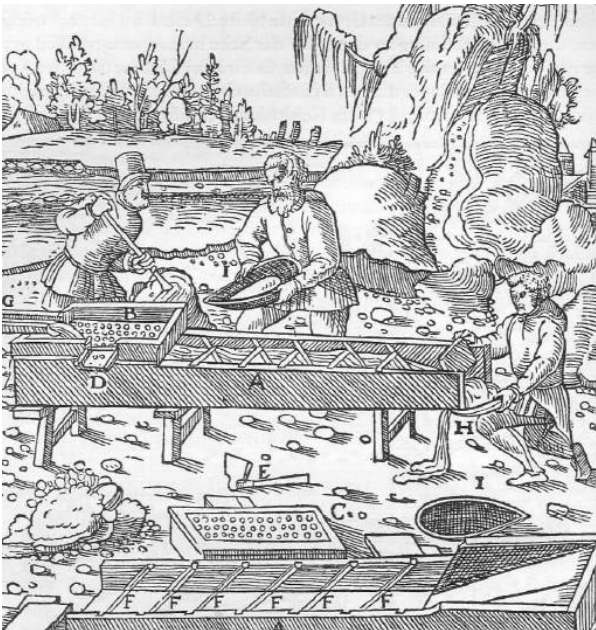
Abb. 840: Das Verwaschen der Golderze im Trog und im Gerinne mit eingesetzten Brettern. Das Gerinne A. Der Trog B. Sein umgekehrter Boden C. Sein seitlicher Auslaß D. Eine eiserne Krücke E. Die Brettchen F. Das Wassergerinne G. Der Sichertrog, in dem das, was sich abgesetzt hat, aufgefangen wird H. Ein Sichertrog, in dem es verwaschen wird I.
