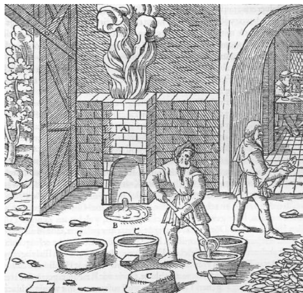
Abb. 1119: Ofen zum Verschmelzen der Zwischenprodukte. Der Ofen A. Der Vorherd B. Längliche Formen C.
