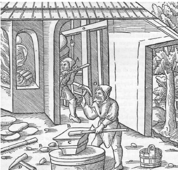
Abb. 1117: Entnahme von Proben des Garkupfers. Das zugespitzte Probeisen A. Die dünne Kupferhaut B. Der Ambos C. Der Hammer D.
