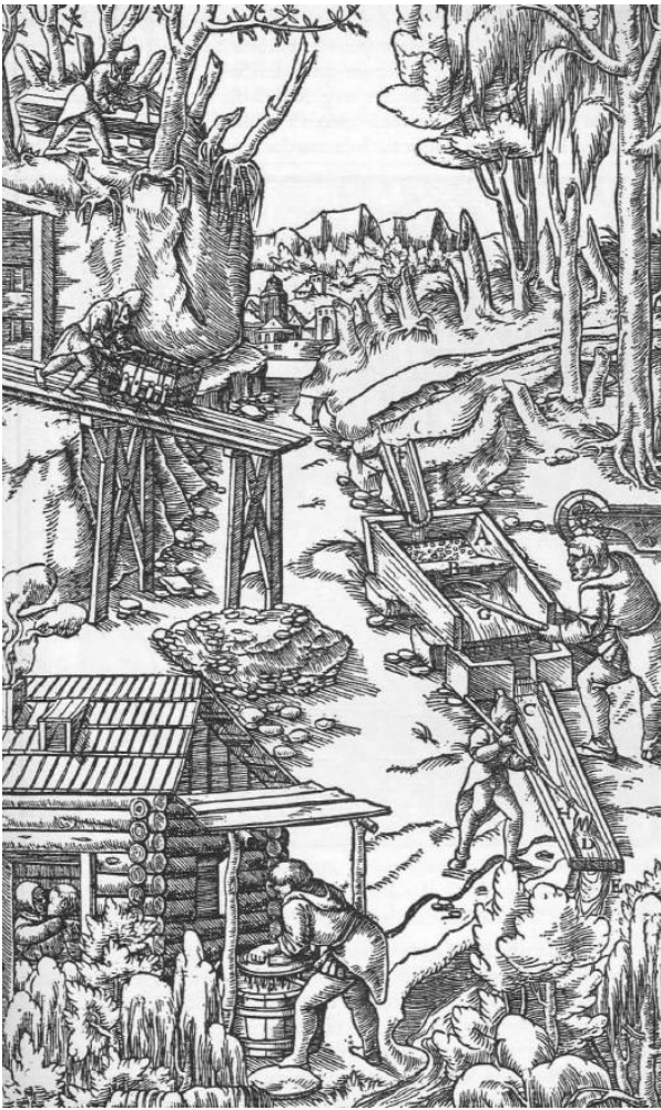
Abb. 858: Das Waschen der Zinnerze im Trog und Graben. Der Trog A. Das Blech B. Der Graben C. Die Brettchen D. Der Sumpf E. Das kleine Gerinne F. Die Kiste G. Der Krähl H.
