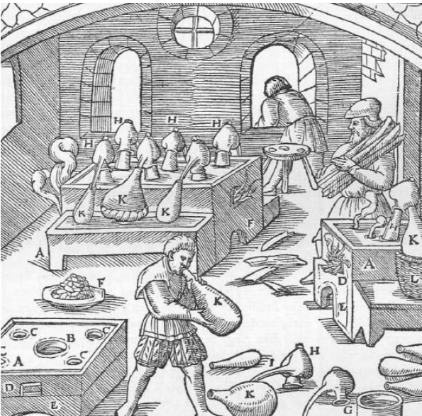
Abb. 1001: Die Bereitung des Scheidewassers. Der Ofen A. Seine runde Öffnung B. Die Windlöcher C. Die Ofentür D. Das Windloch unter dieser E. Der Tiegel F. Kolben G. Helme H. Die Helmschnauze I. Vorlagen K. Der Korb, in den die Vorlage gelegt wird, damit sie nicht zerbricht L.
