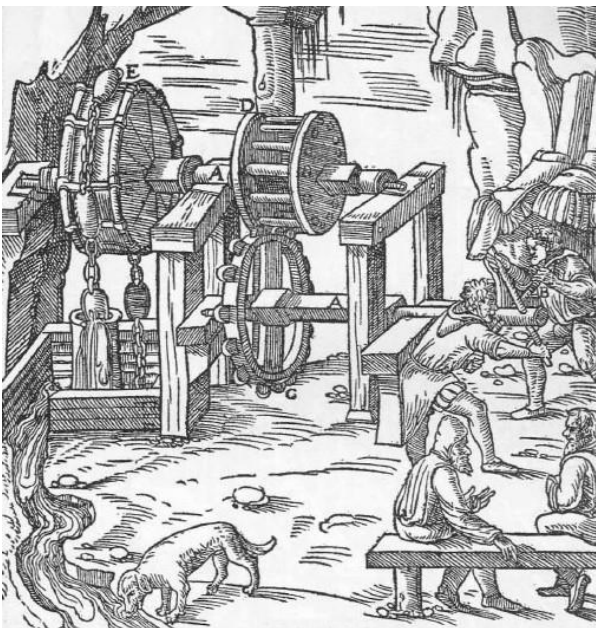
Abb. 636: Heinzenkunst mit Antrieb durch Handhaspel und Vorgelege. Die beiden Wellen A. Die Haspelwinden B. Das Zahnrad C. Das Getriebe D. Der Kettenkorb mit eingeschlagenen Klammern E.
