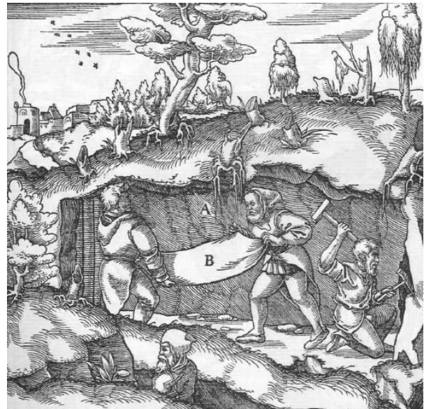
Abb. 649: Wetterversorgung durch Wedeln mit einem Tuche. Der Stollen A. Das Tuch B.
