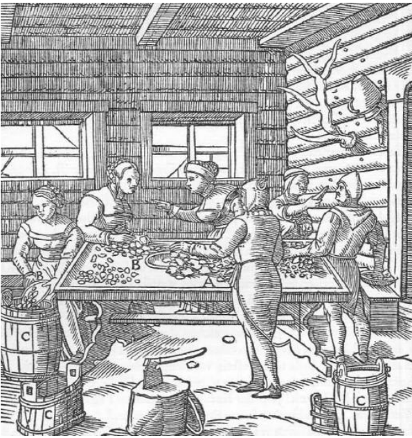
Abb. 801: Das Klauben der Erze. Eine lange Klaubetafel A. Tröge B. Erzfäßchen C.
