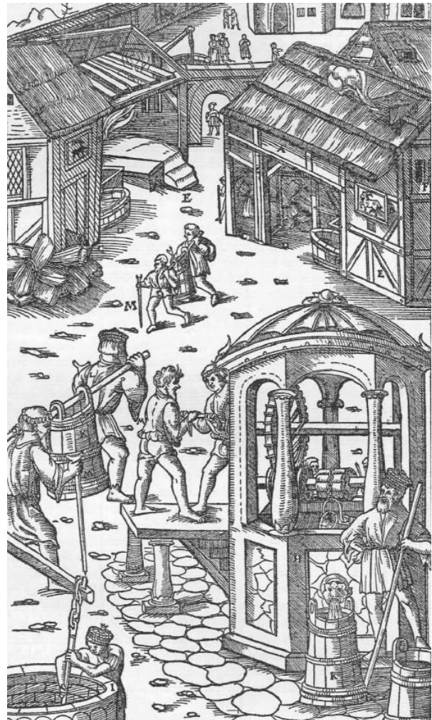
Abb. 1202: Solbrunnen und Sudhütten. Die Sudhütten A. Gemalte Bilder B. Die erste Abteilung der Hütte C. Die mittlere Abteilung D. Die hintere E. Zwei kleine Fenster in der hinteren Wand F. Ein drittes Fenster im Dach G. Brunnen H. Eine andere Art Brunnen I. Bottich K. Tragstange L. Gabelförmige Stöcke, auf welche die
