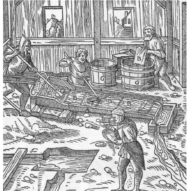
Abb. 829: Das Waschen der Erze auf dem Planenherd. Die Pfosten A. Die Planen B. Das Haupt des Herdes C. Das kleinere Gerinne D. Der Trog E. Die Kisten F. Die Fässer G.
