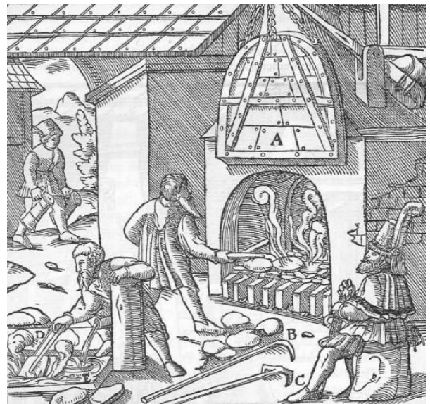
Abb. 1114: Das Herausnehmen der Darrlinge. Die hochgezogene Tür A. Der Haken B. Der zweizinkige Krähl C. Die Zange D. Der Wasserbehälter E.
