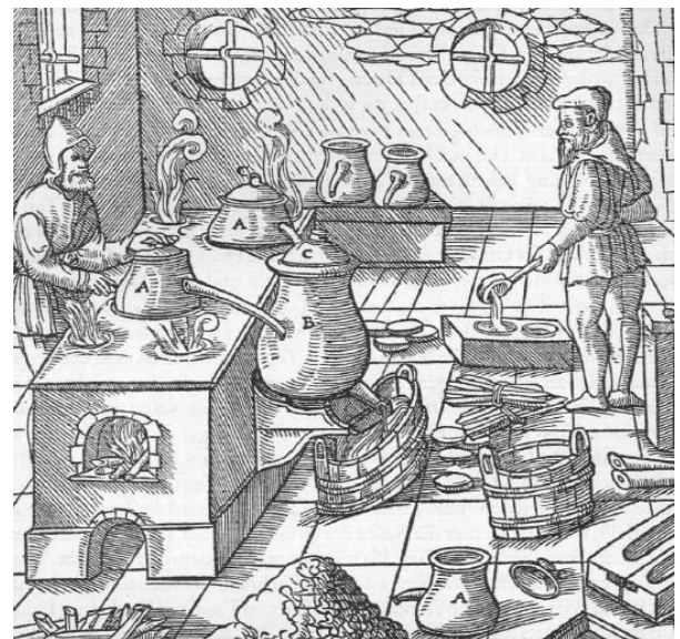
Abb. 1218: Die Gewinnung von Schwefel durch Sublimation aus mit Nasen versehenen Töpfen. Die Gefäße mit Nasen A. Das Gefäß ohne Nase B. Der Deckel C.
