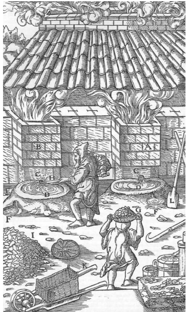
Abb. 916: Großer Spurofen für die Roharbeit. Zwei Ofen A B. Der Stich des Ofens C. Der dicht am Ofen befindliche Vorherd D. Sein Stich E. Der zweite Vorherd F. An den ersten Ofen tritt ein Arbeiter heran, der einen mit Kohlen gefüllten, aus Holzspänen geflochtenen Korb trägt G. Am zweiten Ofen steht ein Schmelzer, der mit einem eisernen Haken die Ansätze entfernt, die sich im Stich gebildet haben. Der eiserne Haken H. Kohlenhaufen I. Karren mit einem aus dicken Ruten geflochtenen Korb, in dem die Kohlen abgemessen werden K. Eiserner Spaten L.
