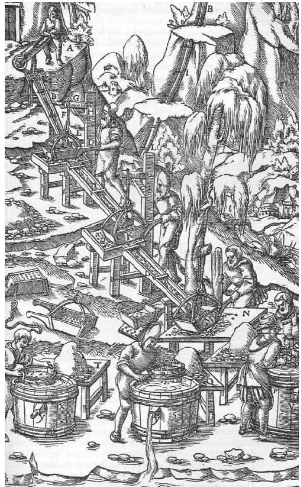
Abb. 817: Das Durchlassen der Erze auf sechs Sieben. Der Karrenläufer, der das Haufwerk heranfährt A. Das erste Gerinne B. Das erste Kastensieb C. Seine Handhaben D. Dessen Bögen E. Der Strick F. Der Balken G. Die Säule H. Das zweite Gerinne I. Das zweite Kastensieb K. Das dritte Gerinne L. Das dritte Kastensieb M. Die dritte Bühne N. Das erste Handsieb O. Das erste Faß P. Die zweite Bühne Q. Das zweite Handsieb R. Das zweite Faß S. Die dritte Bühne T. Das dritte Handsieb V. Das dritte Faß X. Der Spund Y.
