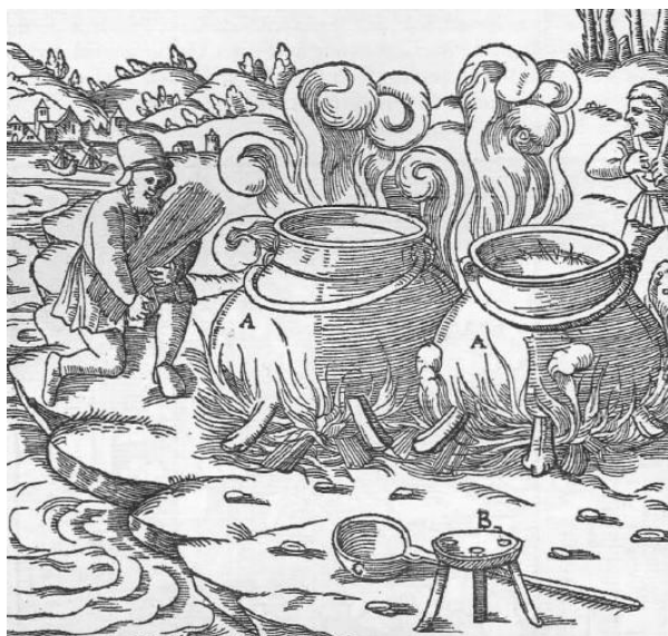
Abb. 1206: Das Eindampfen der Sole in großen Töpfen. Die großen eisernen Töpfe A. Der Dreifuß B. Großer Schöpflöffel C.
