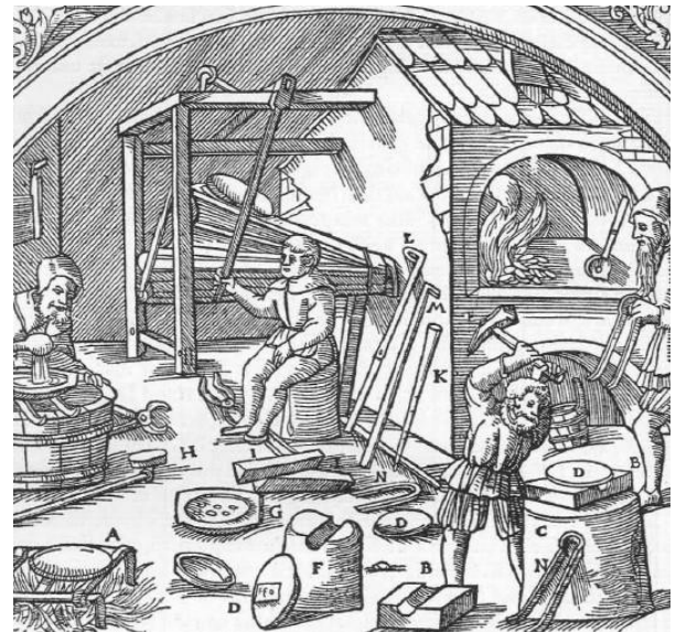
Abb. 1015: Vorbereitende Arbeiten und Feinbrennen des Silbers im Test. Der Rost A. Die Messingunterlage B. Der Holzklotz C. Das Silberstück D. Der Hammer E. Der Holzklotz, in der Mitte vertieft F. Der Trog mit Löchern G. Das Rundholz, an einem Eisen befestigt H. Tannenholzscheite I. Die Eisenstange K. Das Gezähe mit Aushöhlung (Probelöffel) L. Das Gezähe mit Ring; das Gezähe, dessen Ende aufgebogen ist M. Das Gezähe in Gestalt einer Klemme N.
