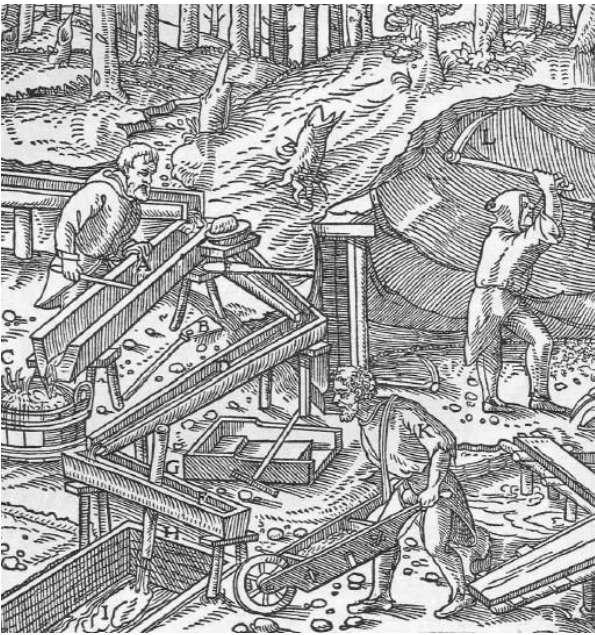
Abb. 854: Das Waschen der Zinnerze in Rinnen. Der Trog A. Die hölzerne Schaufel B. Das Faß C. Das Gerinne D. Die kleine hölzerne Schaufel E. Das Quergerinne P. Der Zapfen G. Das niederfallende Wasser H. Der Graben I. Ein Karrenläufer, der das Waschgut herbeischafft K. Eine Hacke, dem Entenschnabel ähnlich, mit der der Arbeiter das steinfreie Seifengut gewinnt L.
