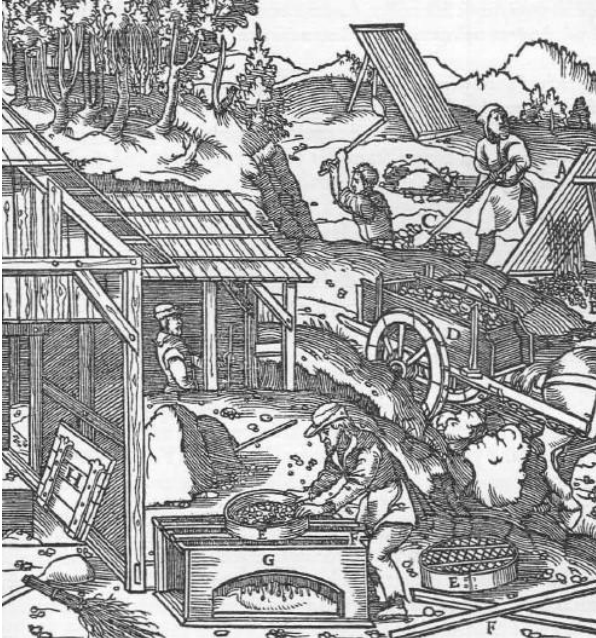
Abb. 911: Durchwurf und Sieb zum Absieben von Lehm. Das Stangensieb A. Die Stütze B. Eine Schaufel C. Ein zweirädriger Karren D. Das Sieb E. Die Querstäbe F. Das Sammelgefäß G. Die abgedeckte Grube H.
