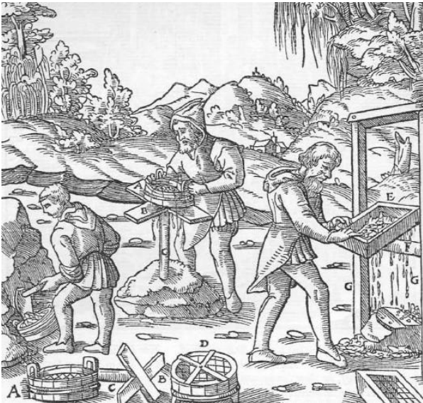
Abb. 815: Das Sieben der gepochten Erze. Das Sieb A. Die Brettchen B. Der Pfahl C. Der Boden des Siebes D. Der offene Kasten E. Das Querholz F. Die Säulen G.
