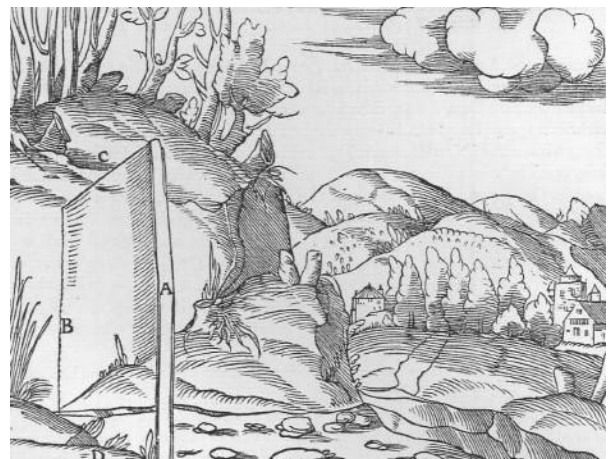
Abb. 329: Anfang, Ende und Seiten eines Flözes. Der Ursprung des Flözes A. Sein Ende B. Seine Seiten C, D.
