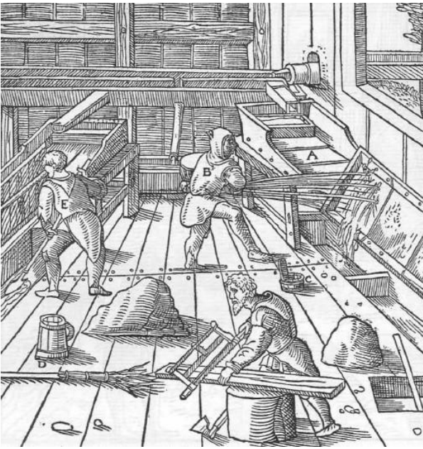
Abb. 830: Das Waschen der Erze auf dem Wendeherde. Der Herd A. Der Arbeiter, der das Wasser auf die Planen spritzt B. Die Kanne C. Eine andere Art von Kannen D. Ein Arbeiter, der das Erz oder die Graupen aus dem Graben aushebt E.
