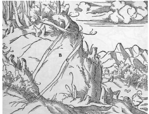
Abb. 304: Zwei durch ein Zwischenmittel getrennte Gänge. Gänge A, C. Das Zwischenmittel B.
