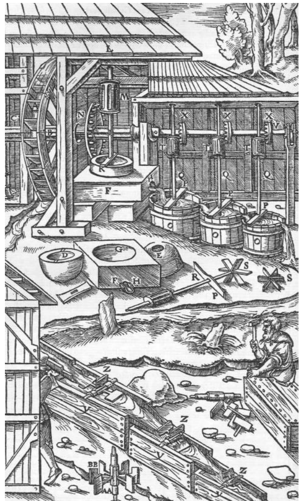
Abb. 822: Das Pochen und Amalgamieren der Golderze. Das Waffenrad A. Die Welle B. Die Pochstempel C. Der runde Eintrag der Mühle D. Das Loch in der Mitte E. Der untere Mülstein F. Seine runde Aussparung G. Sein Austrag H. Die eiserne Achse I. Deren Querriegel K. Der Balken L. Das Getriebe der eisernen Welle, das aus Spindeln besteht M. Das Zahnrad der Welle N. Die Fässer O. Die Brettchen P. Die stehenden Wellen Q. Ihr verdickter Teil R. Ihr Rührer S. Die Getriebe, die aus Sprossen bestehen T. Die mit der Hauptwelle gekuppelte wagrechte, schwache Welle V. Ihre Zahnräder X. Drei Gerinne Y. Deren Wellen Z. Die eingesteckten Brettchen AA. Die angeschlagenen Brettchen BB.
